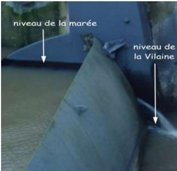
Le barrage d'Arzal bloque l'onde de marée qui engendrait des inondations fréquentes sur le secteur redonnais par concordance entre une marée haute à fort coefficient et une crue de la Vilaine ou de l'Oust. Il n'est vraiment efficace que lorsque le débit de la Vilaine est inférieur à 800 m<sup>3</sup>/s, mais il permet de réduire fortement la fréquence des crues et la durée des inondations en toutes zones.
