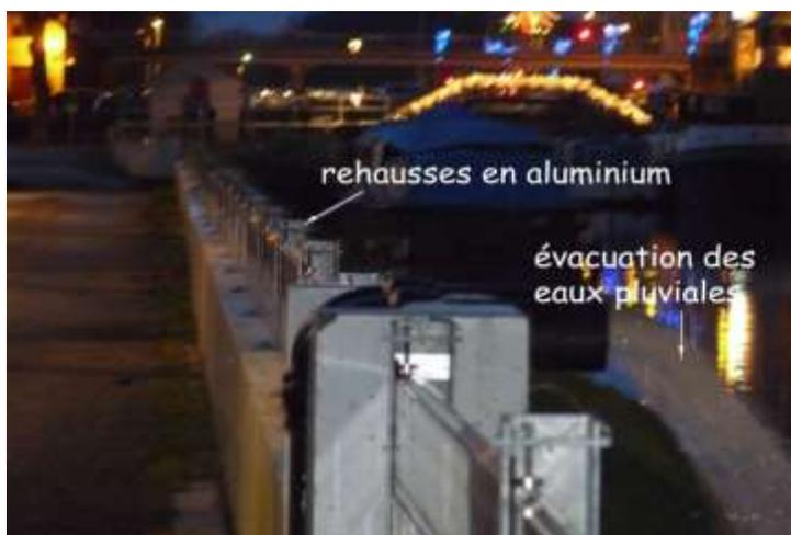
Ainsi, quelques secteurs urbains ont fait l'objet d'aménagements pour protéger des habitations et entreprises : construction de murets, rehausses amovibles, pompage des eaux pluviales... Les nouveaux bâtiments installés dans des zones inondables constructibles comportent des pilotis.
